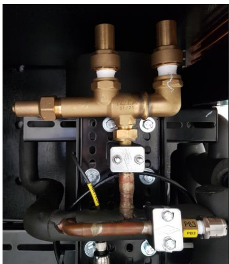
Figure 36 : Soupapes de sécurité avec vanne d'inversion sur la bouteille réservoir
