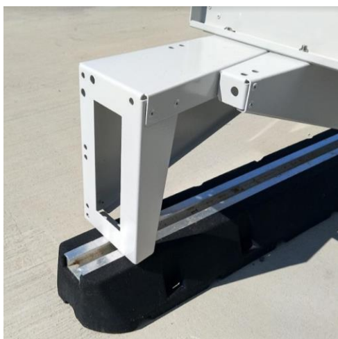
Figure 58 : Montage sur dalle de béton avec plots anti-vibration
