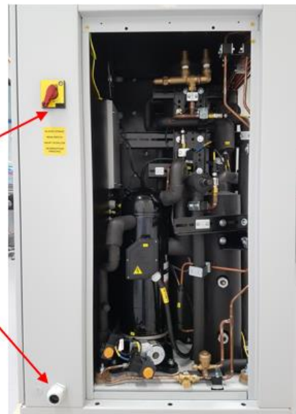
Figure 19 : Interrupteur principal et alimentation
