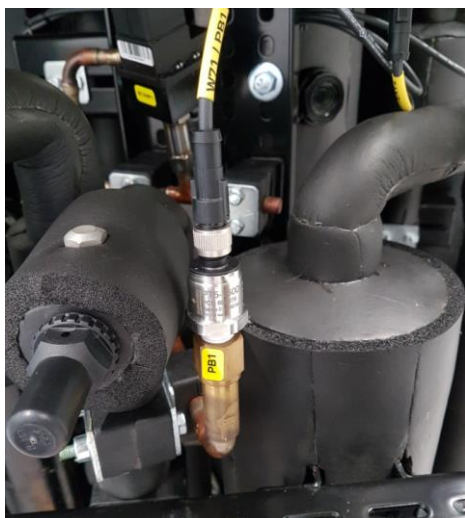
Figure 37 : Transmetteur de pression BP
