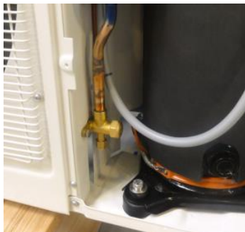
Figure 23 : Raccord pour la maintenance, situé sur la ligne liquide
