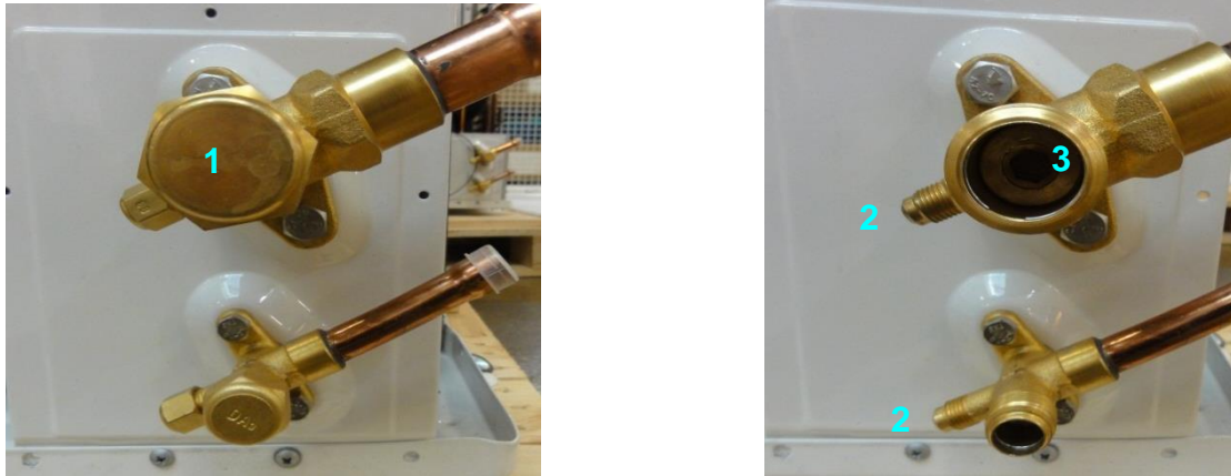
1 = Capuchon de vanne 2 = Vanne Schraeder 3 = Filetage à section hexagonale
